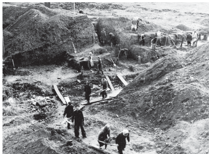
Восстановление плотины на пруду в Голицыно, лето 1950 г.
